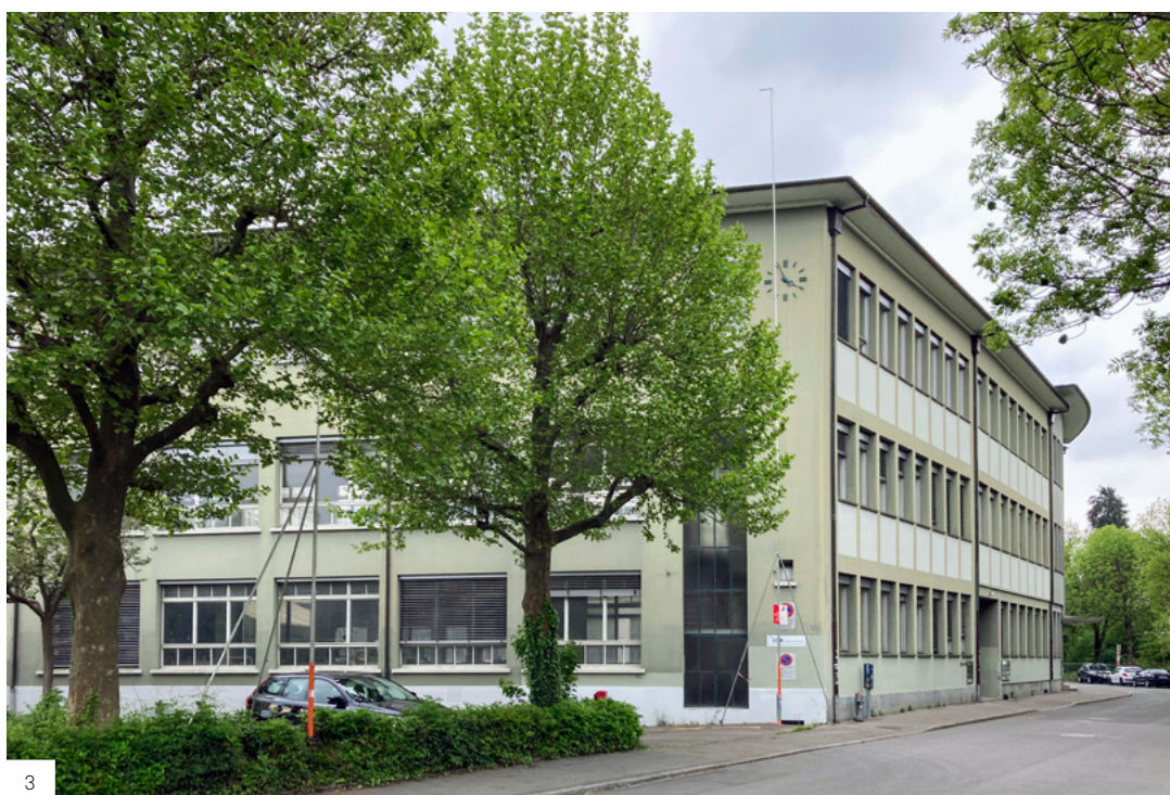
3 Areal Mikron vor dem Abriss.
