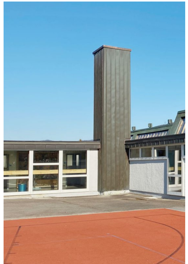
Dans la cour, une cheminée évoquant une usine. JEAN KLEIBER
