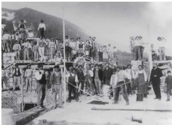
Les ouvriers posent sur le chantier, en 1904. COLLECTIONS MÉMOIRES D'ICI
