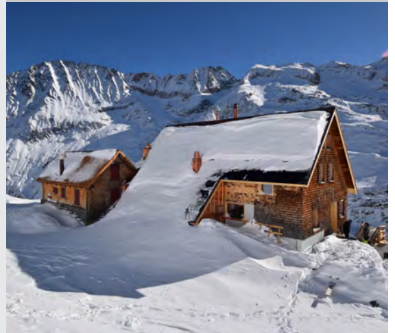
Die Gaulihütte SAC nach der Sanierung. Foto: Joris Rothenbühler
