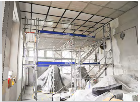
Malerarbeiten im Maschinensaal mit Flächengerüst. Foto: Simon Weiss
