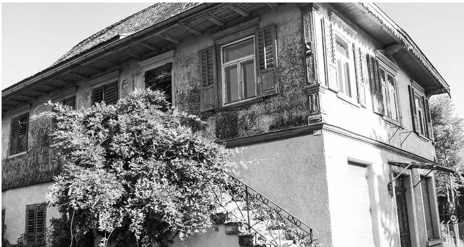
Die ehemalige Mühle «Grünau» in Horn wird unter Schutz gestellt. Der Heimatschutz erachtet auch die Nebengebäude, die mit der «Grünau» ein Ensemble bilden, als schutzwürdig.
